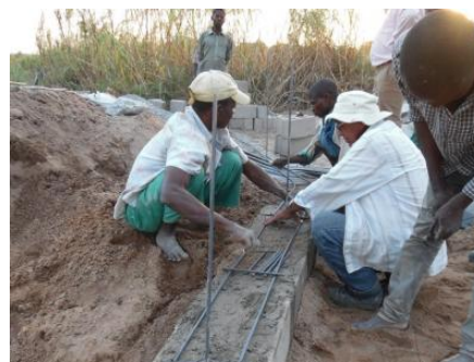
Строительство подземной дамбы
